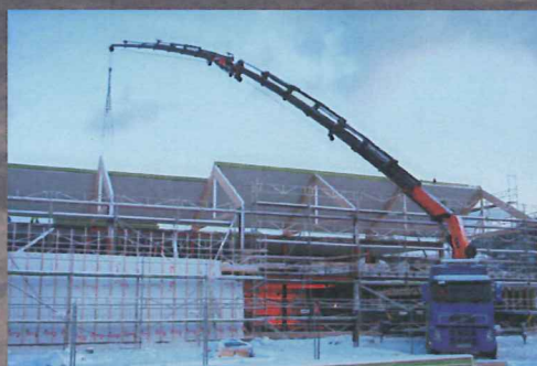
4 akslet bil med 100 t/m kran med jibb og vinsj, rekkevidde 33 meter. (2006 mod)
